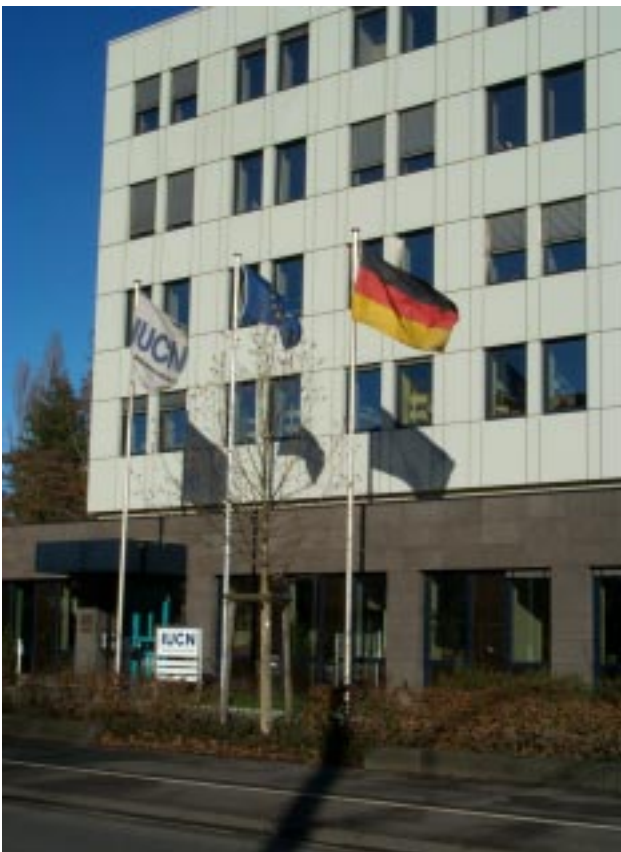
Edificio del Centro de Derecho Ambiental, Bonn, Alemania
